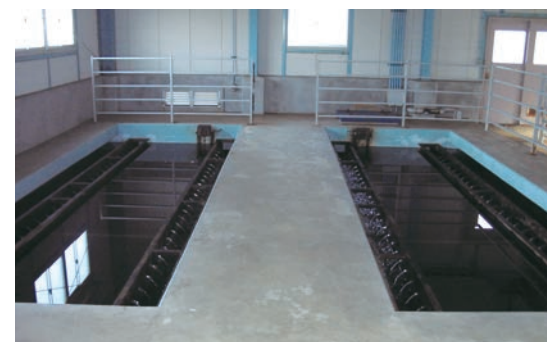
ちんち 〈沈でん池〉 薬を入れて、目に見えない小さなごみをしずめます。
