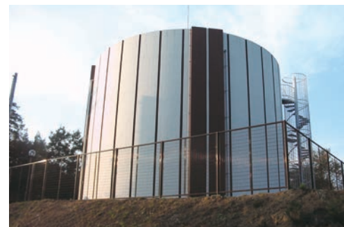
はいすいち 〈配水池〉 飲めるようになった水は、送水ポンプでここに上げます。
